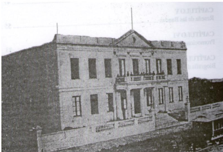
Edificio que ocupó la Escuela de Artes y Oficios en la avenida 18 de julio y Eduardo Acevedo.
